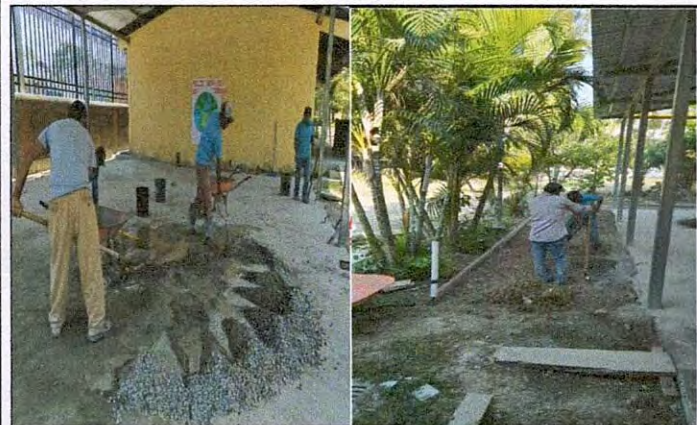
Foto 1: fundicion de extencion, ampliacion de torta de cemento en area de usos Múltiples
